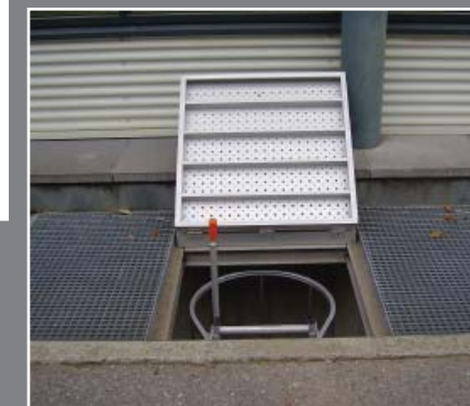
Crosse escamotable facilitant l'accès à l'échelle ou l'accès à la sortie
